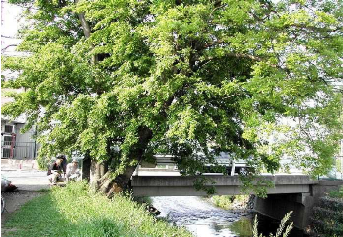
大工ノキは残った 川越 砂久保橋
