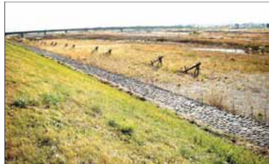
甲府盆地を守ってきた 信玄堤の水制「聖牛」
