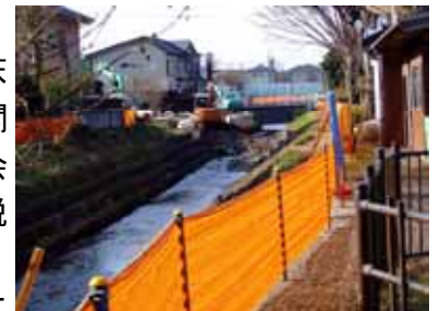
入曾橋上流拡幅工事
