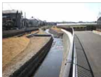
工事完成直後
