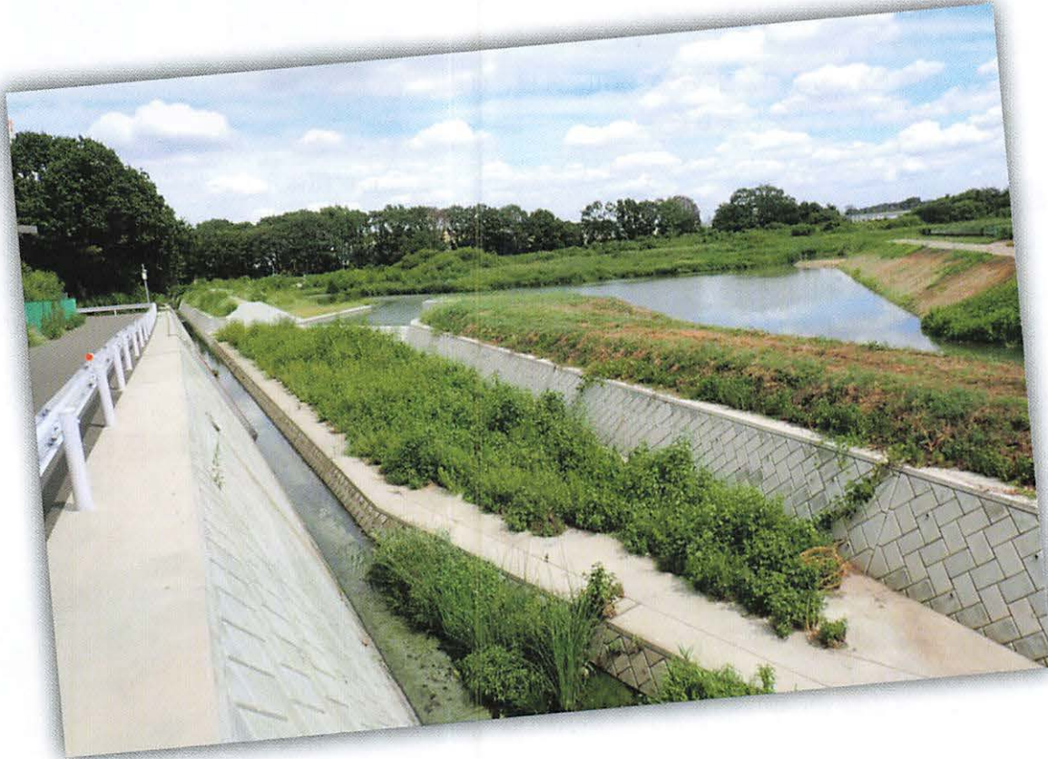
改修後の不老川(左水路)と北池を見る
