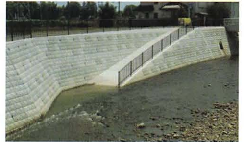
河川管理用通路のスロープ(坂路)を橋と橋の間に造成 9か所
